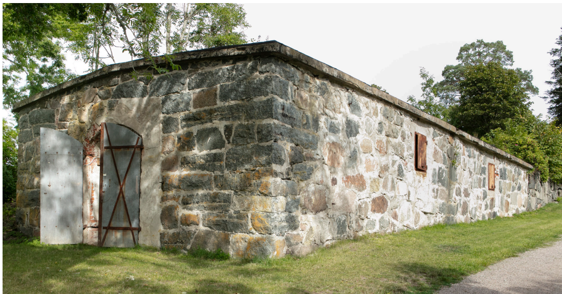
Fig. 3. Potatiskällaren är en rejäl pjäs, värd sin plats som det forna säteriets matförråd. Invändigt mäter golvet ca 17x5 m under ett vackert och 2,8 meter högt valv inom de upp till två meter tjocka väggarna. I samband med installationen av skyddsluckorna och dörrarna år 1939-1940 ersattes några av originalstenblocken med tegelstenar och puts. De yttre luckorna är av tjock stålplåt medan de inre luckorna och de dubbla lagren ytterdörrar är zinkplåtskodda konstruktioner med tjocka träkärnor. Den totala kostnaden för ombyggnationen var knappt 6000 kr och betalades av Universitets brandskyddsfond. Foto: författaren.
